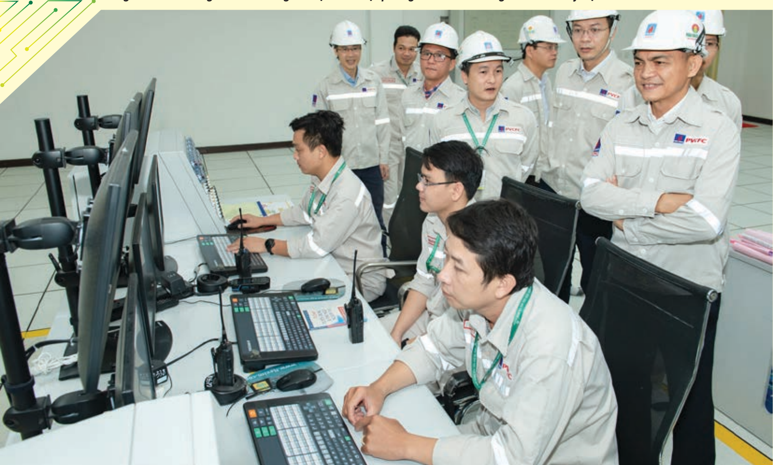
Tổng Giám đốc đang kiểm tra công tác vận hành tại phòng điều khiển trung tâm Nhà máy Đạm Cà Mau
