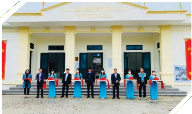
Công trình Trung tâm Giáo dục Cộng đồng thôn Trung Hòa, với tổng mức đầu tư 3 tỷ đồng, được PVCFC tài trợ toàn bộ
