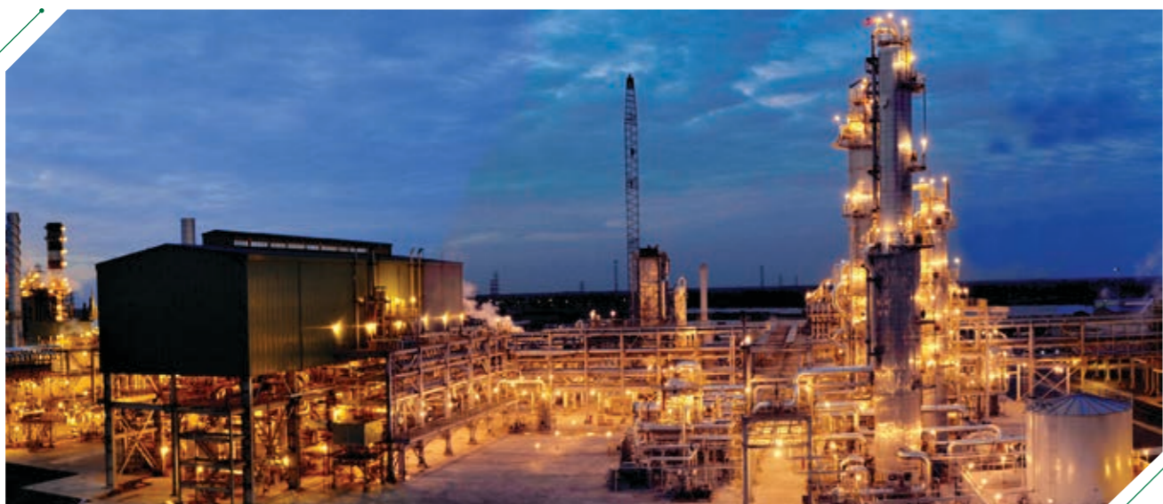
Hình chụp tại Nhà máy Đạm Cà Mau
